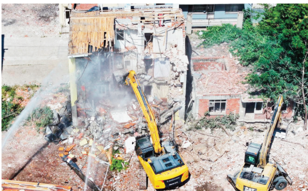
Kemal Baysak Bulvarı'nı Şemikler Mahallesi ve Anadolu Caddesi'ne bağlayacak imar yolunun çalışması sürüyor
